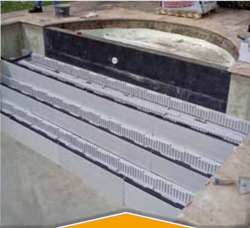
Suppression d'un escalier roman et création escalier plage plus moderne en blocs escalier SolidPOOL® et blocs SolidPOOL® classiques. AM ESPACE PISCINE TPE 71
