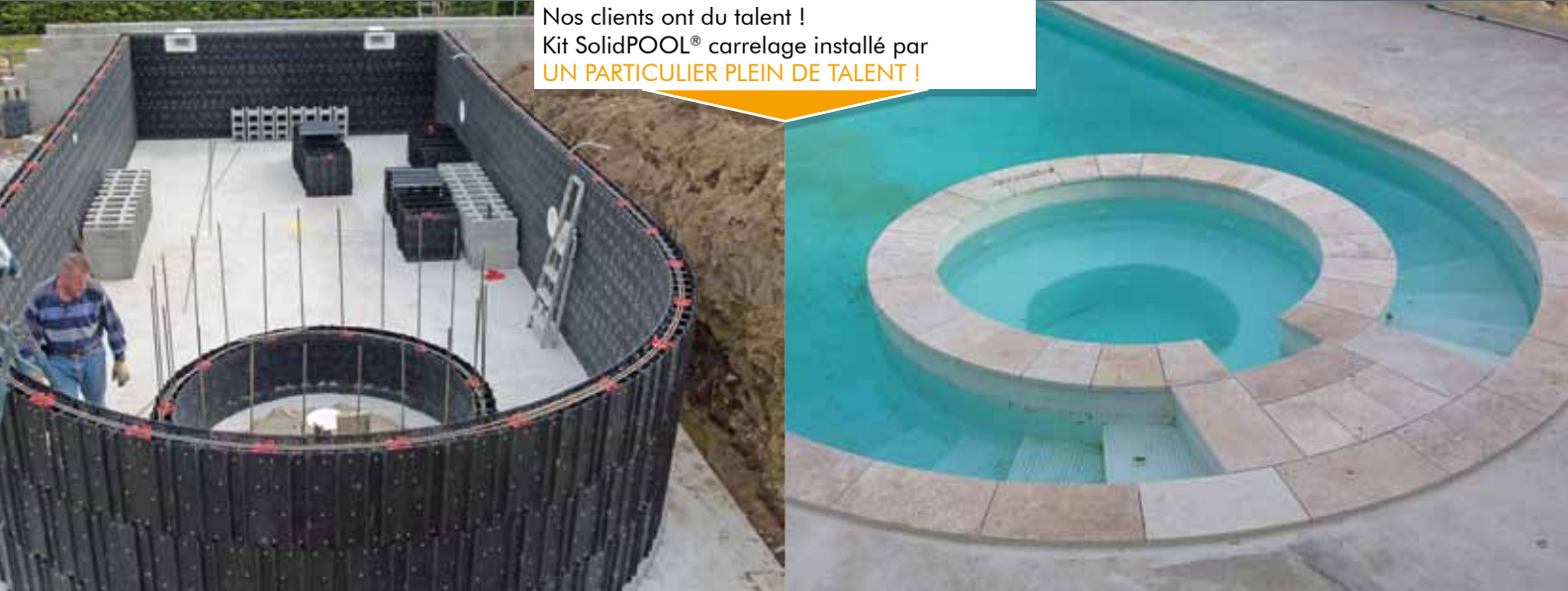
Suppression d'un escalier externe et création escalier plage en blocs escalier SolidPOOL® et blocs SolidPOOL® classiques, pour pouvoir installer un volet. AM ESPACE PISCINE TPE 71
