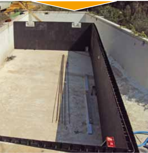
Rénovation avec des blocs SolidPOOL®, ASSISTEAU TPE 30
